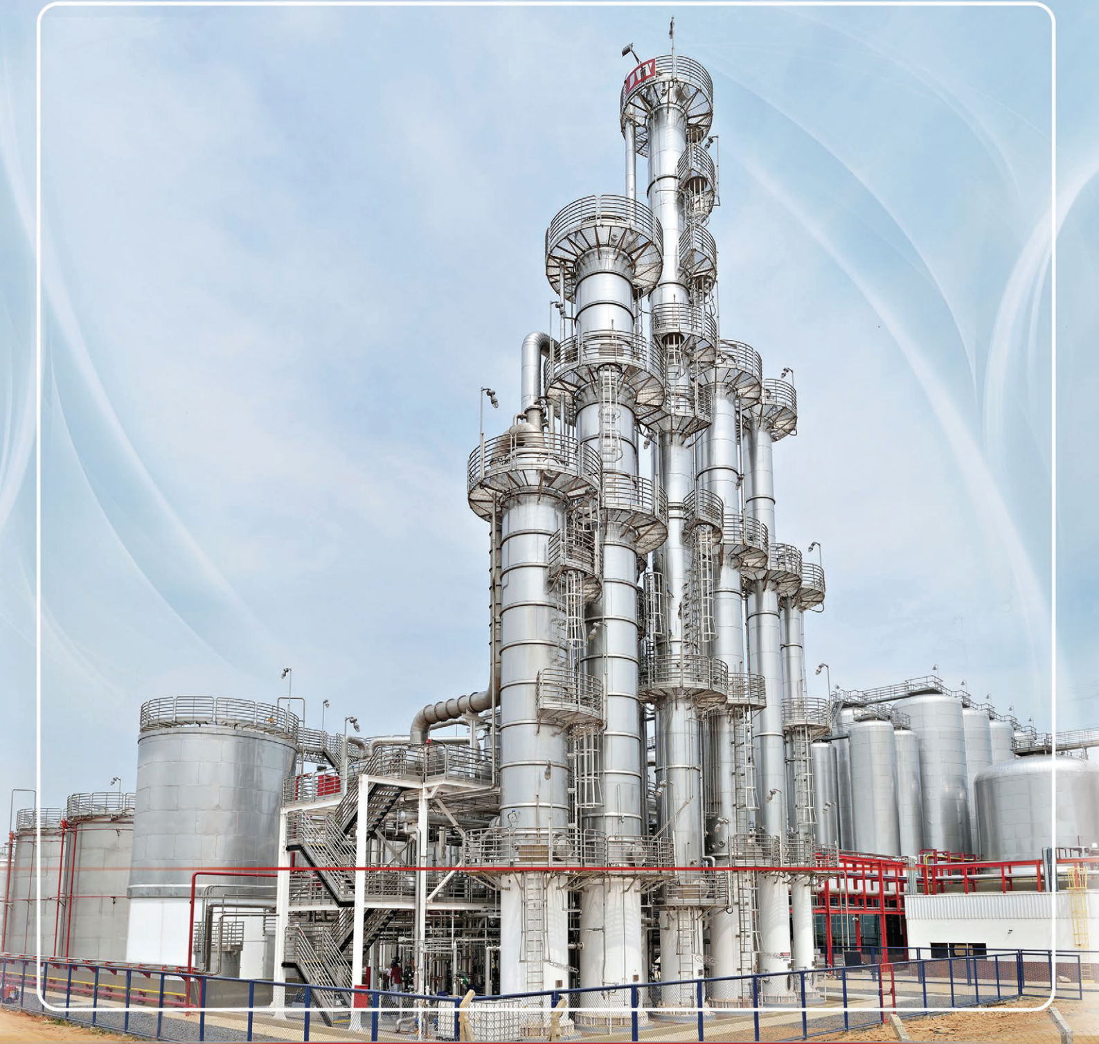
Planta para Etanol Neutro em Duplo Efeito - Capacidade 65.000 Litros/dia
